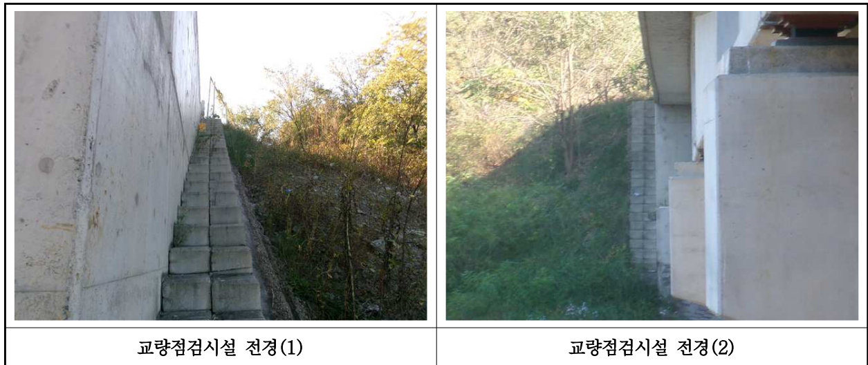
【사진 22.3.25】 교량 점검시설 전경
