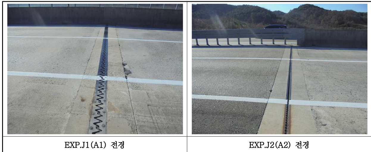
【사진 22.3.16】 신축이음장치 전경
