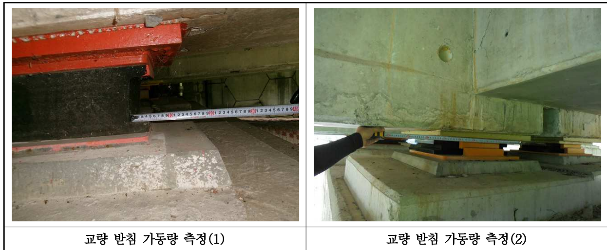
【사진 22.3.15】 교량받침 이동량 측정
