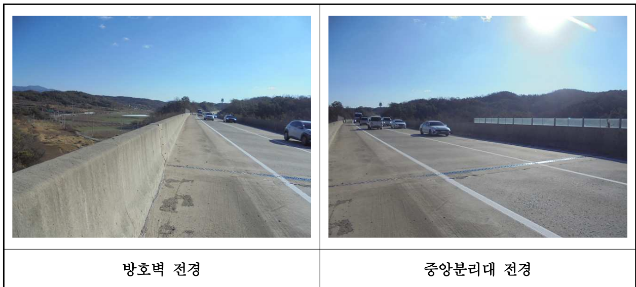
【사진 22.3.23】 방호벽 및 중앙분리대 전경
