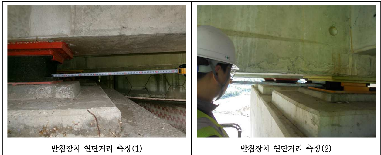
【사진 22.3.14】 교량받침장치 연단거리측정
