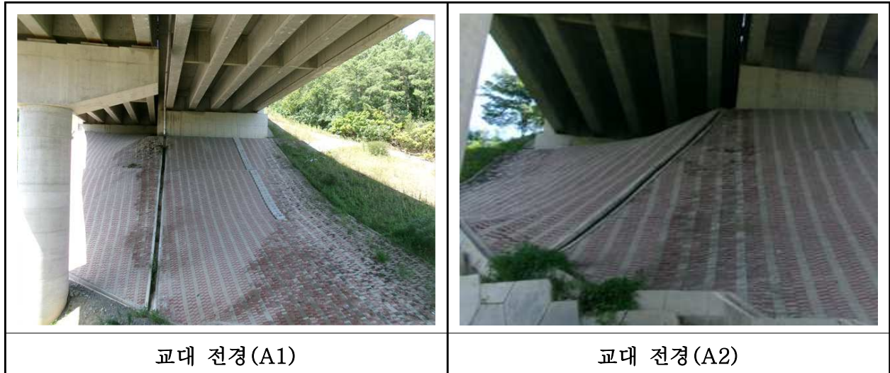
【사진 22.3.8】 교대 전경
