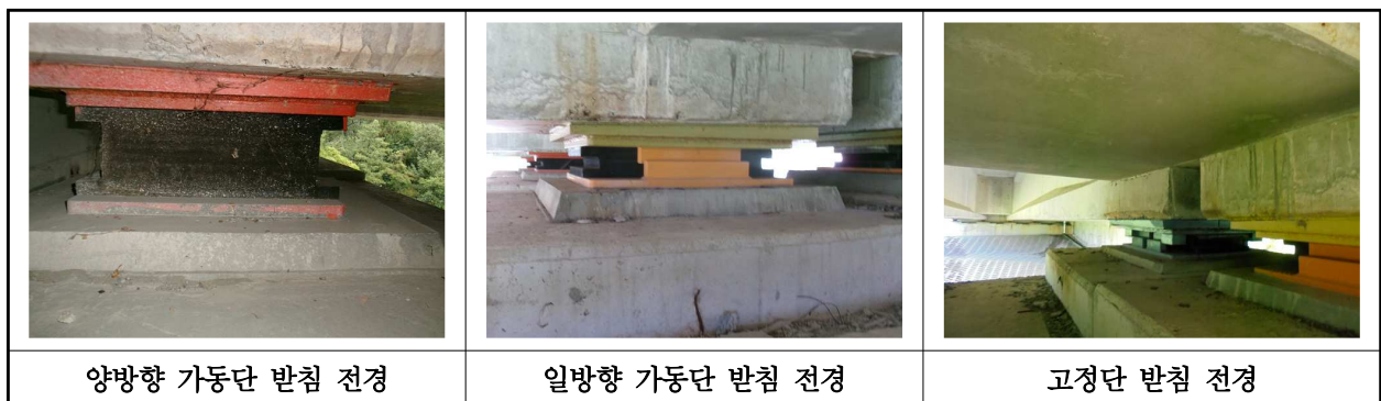
【사진 22.3.12】 교량받침 전경
