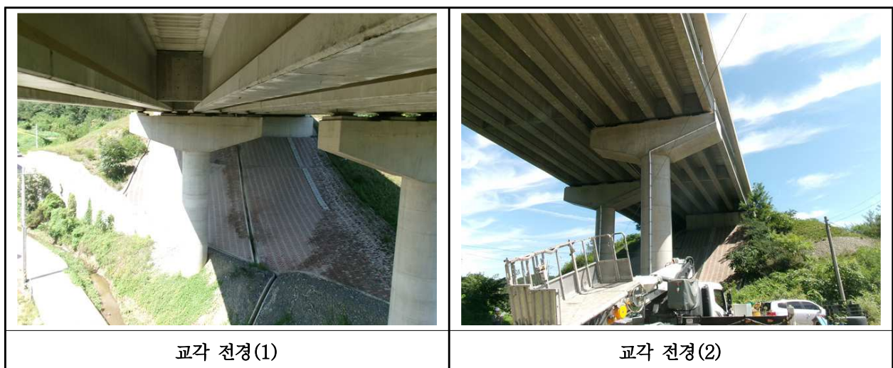
【사진 22.3.35】 교각 전경
