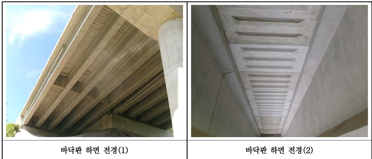
【사진 22.3.27】 바닥판하면 전경
