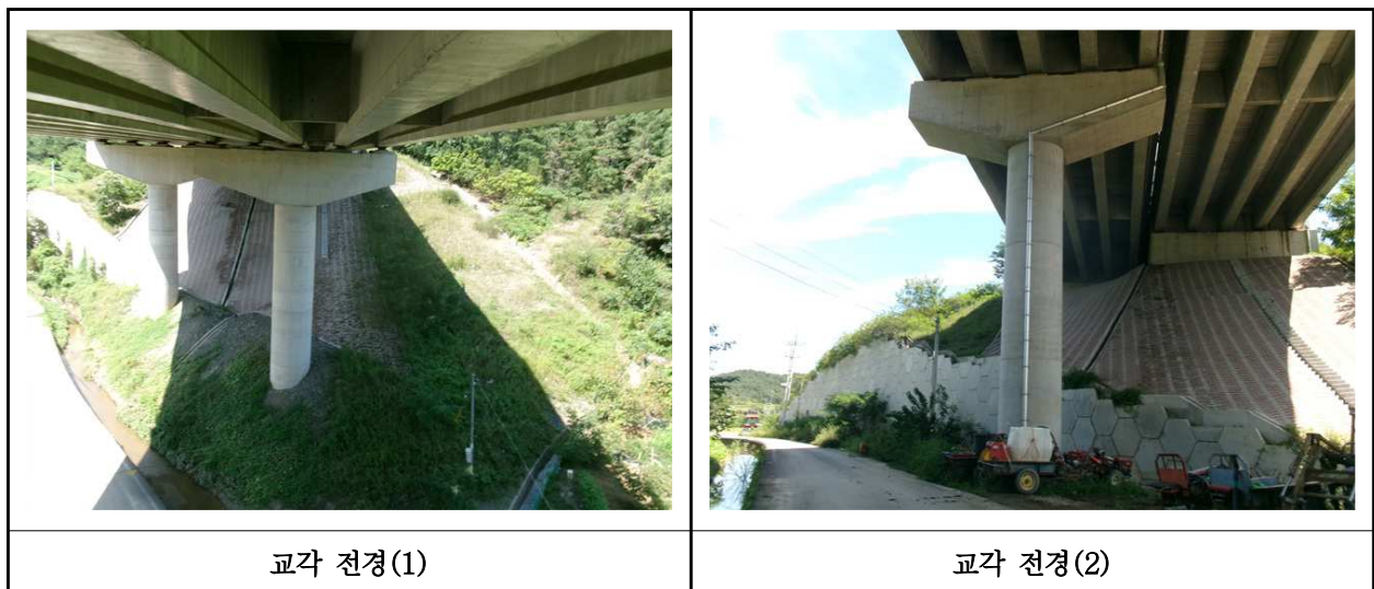
【사진 22.3.10】 교각 전경
